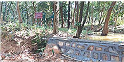
ရေထွက် ကွန်ကရစ်တမံ တည်ဆောက်ခြင်း
