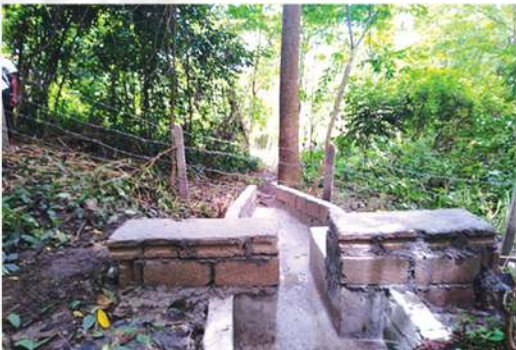
ကွန်ကရစ်ရေသွယ်မြောင်း တည်ဆောက်ခြင်း
