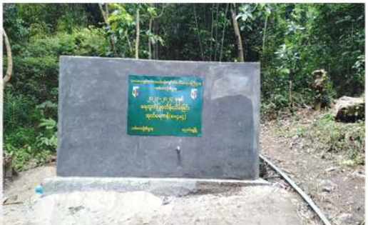
ကွန်ကရစ် ရေရကန် တည်ဆောက်ခြင်း
